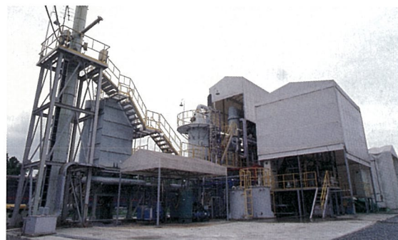
5ton/일급 폐기물 열분해 응용 파일럿 플랜트 시스템
