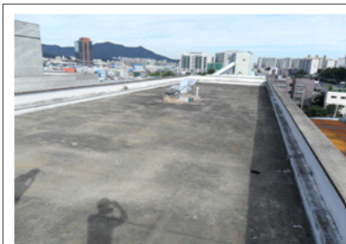
[사진2] 바탕정리-콘크리트 바닥
