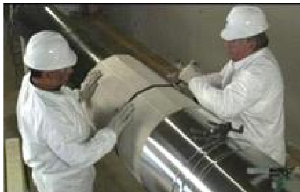
그림 11. 극저온 단열시스템 설치 예
