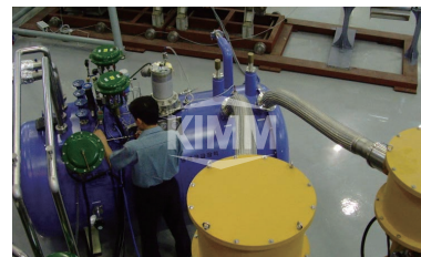
〈 초전도 케이블 냉각시스템 〉
