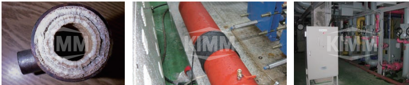
〈 기존 배관 스케일과 개발 설치된 스케일 제거장치 〉
