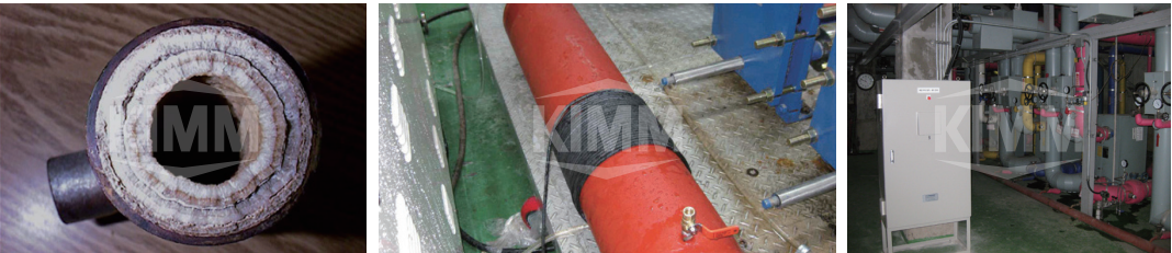
〈 기존 배관 스케일과 개발 설치된 스케일 제거장치 〉
